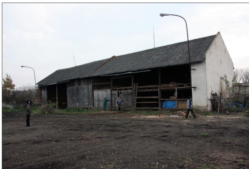
Stará stodola před rekonstrukcí
